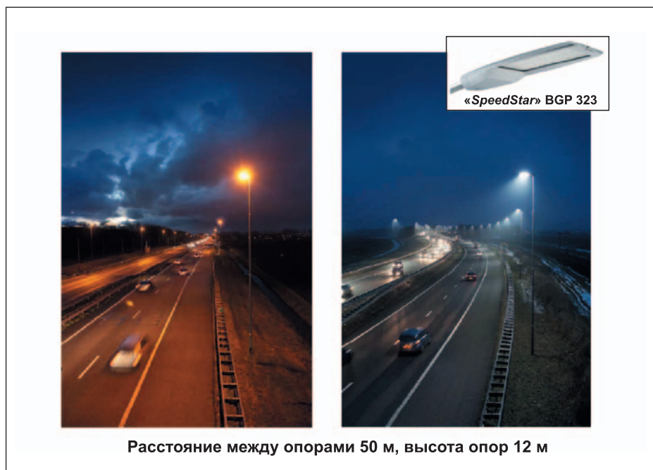
Рис. 11. Модернизация освещения на автостраде А44, Нидерланды. Было (слева): светильники «TrafficVision» SGS306 SON-T250 W 230 V, электромагнитный ПРА, входная мощность 270 Вт. Стало (справа): светильники «SpeedStar» BGP 323 (LED 136), входная мощность 242 Вт, система телеуправления «Starsense» с функцией диммирования до 20% от номинала, срок окупаемости 8,6 лет. (Тариф на электроэнергию €0,124/кВт·ч.)
